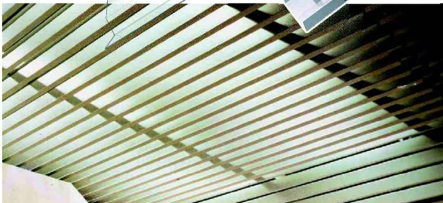
Il controsoffitto a doghe lamellari "SERIE I-100" forma uno schermo ideale per la riduzione visiva della volumetria di un locale e per il mascheramento degli impianti sovrastanti. Offre in modo uniforme un'ottima riflessione alla luce sia diurna che artificiale.
